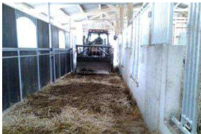
Systèmes de cloisons coulissantes qui permettent d'escamoter les parois entre les boxes pour permettre à un tracteur de passer aisément.
